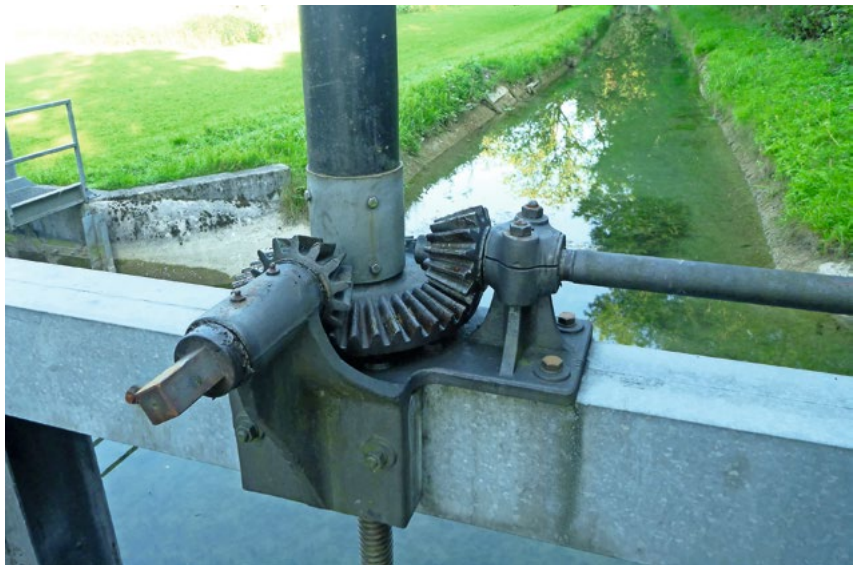
Ein Postulat verlangt, dass der Bund ein Inventar der historischen Wasserkraftanlagen erstellt.
