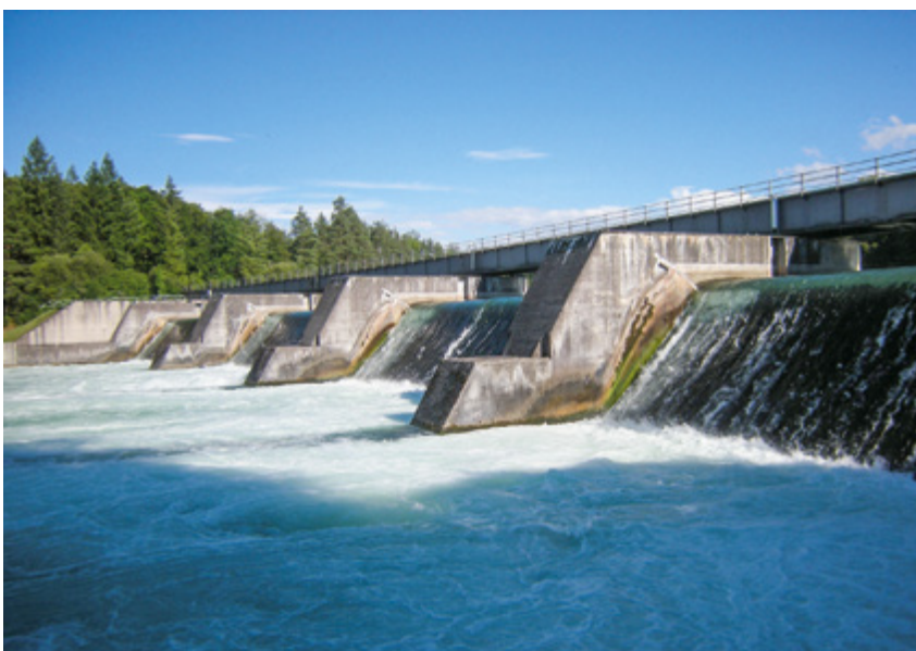
Wasserkraftwerke profitieren künftig von den 2019 getroffenen Änderungen im Wasserrechtsgesetz sowie im Natur- und Heimatschutzgesetz. Im Bild: Stauwehr des Kraftwerks Rheinau.
